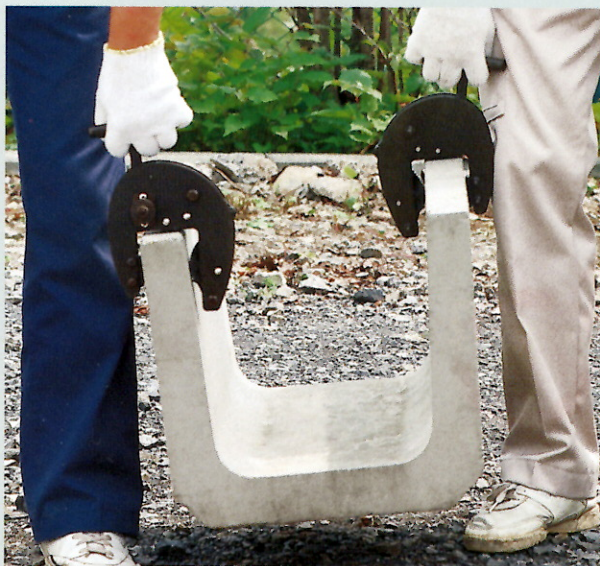
▲手吊り作業中 (写真はS-150です)
